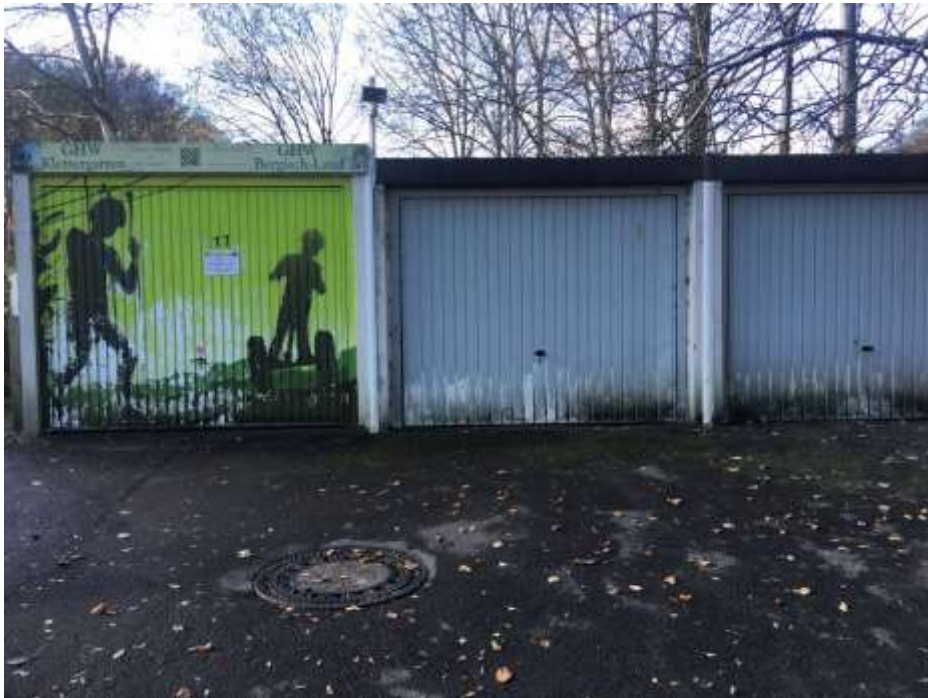
Abb. 3 Die abzubrechenden Garagen
